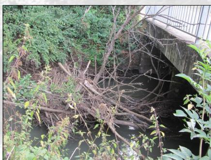
*Embâcle en amont d'un pont, obstruant les écoulements*
